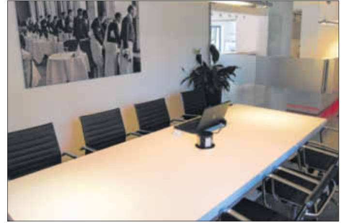
Im Konferenztisch befindet sich ein ausfahrbares CAT-Element mit Strom- und Netzanschlüssen für Laptops etc.
